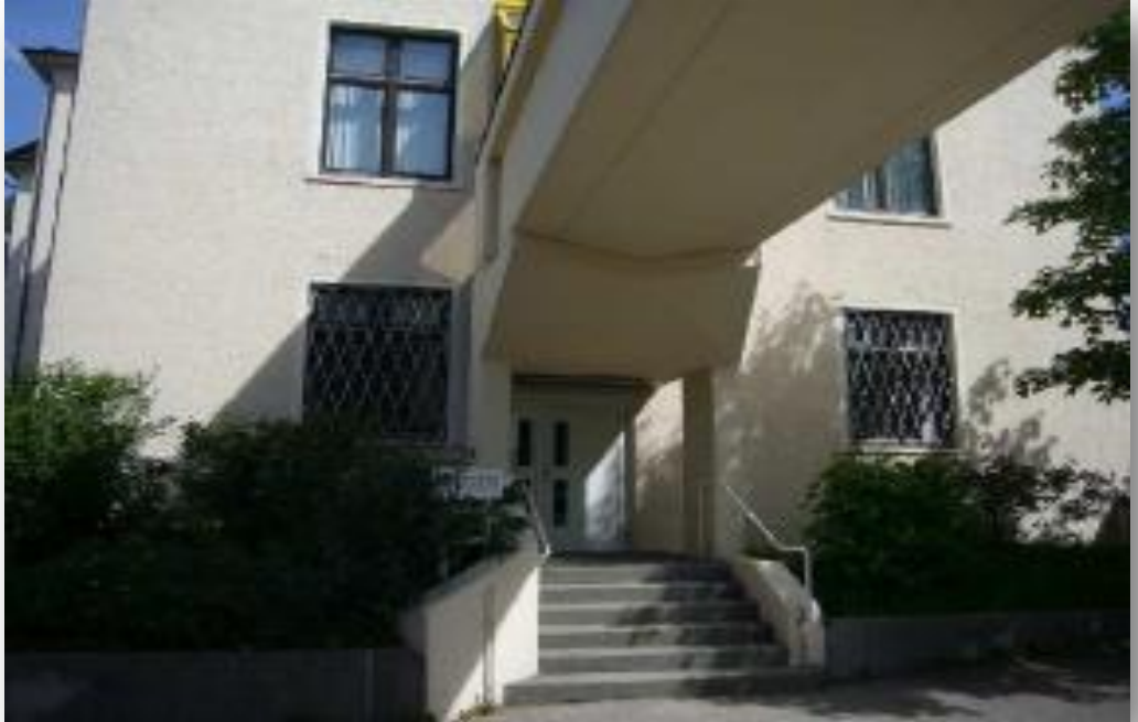
Nebeneingang EG mit Verbindungssteg zum Nachbargebäude
