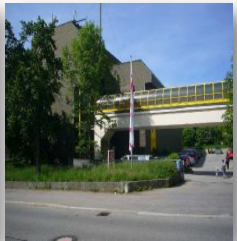
Hauptzufahrt zum Grundstück
